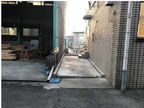
解体工事だけ終わっている現場事務所跡
